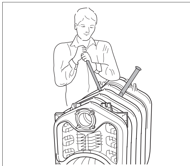
Рис. 27 Разъединение секций котла
