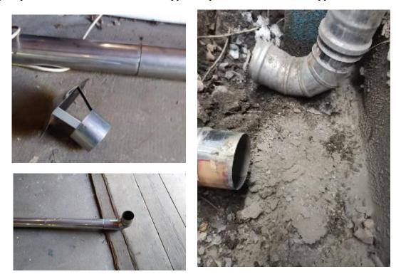
Присоединить дымоход к дымососу, уплотнив стыки термостойкой фольгированой лентой.
