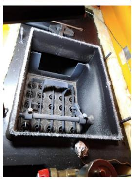
Очистить щеткой и пылесосом камеру теплообменника, сначала верх, затем - низ
