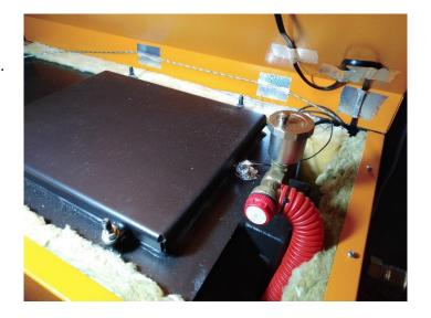
Проверить датчик пламени - вынуть и аккуратно очистить поверхность от нагара, проверить его целостность. Посадить обратно на термостойкий герметик.
