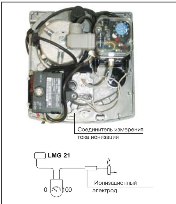
**Замечание :** В том случае, если стрелка амперметра отклоняется в неверном направлении (ниже нуля), нужно поменять местами 2 провода измерительного прибора. Провод «плюс» на место провода «минус» и наоборот.
