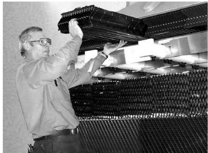
Рисунок 9: Съёмные каплеотбойники
