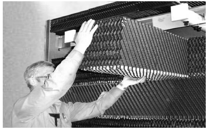
Рисунок 8: Съёмный наполнитель
