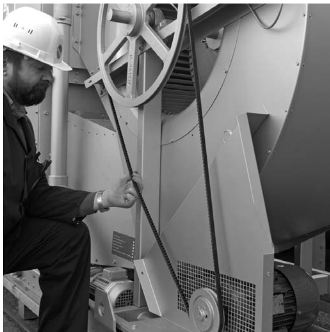
Рисунок 1: Регулировка ремня вентилятора
