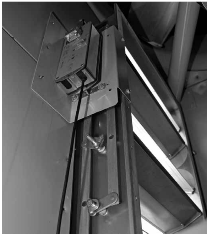
Рисунок 12: Привод регулирующих демпферов на впуске воздуха
