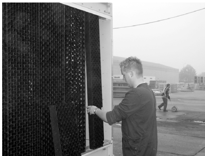
Рисунок 15: Снятие комбинированных экранов на входе
