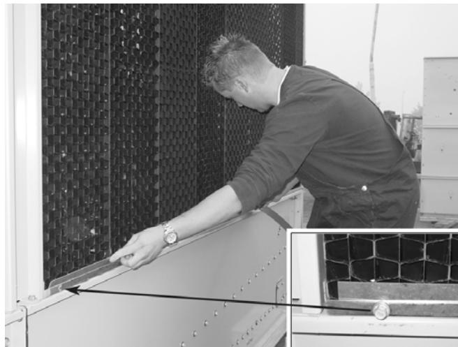
Рисунок 14: Снятие транспортных скоб
