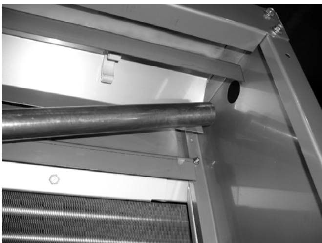
Рисунок 12: Установка медной трубы подачи воды
