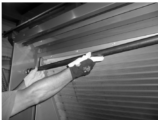
Рисунок 8: Извлеките медную трубу подачи воды
