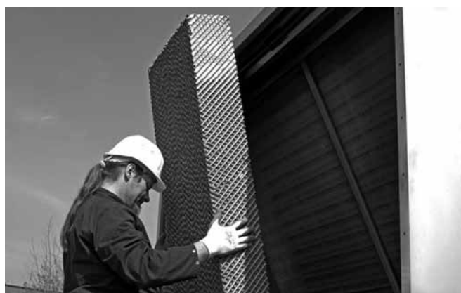
Рисунок 20: Снятие предохладительного материала
