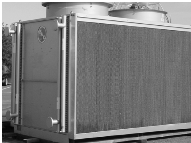
Рисунок 17: Изделие с установленным адиабатическим предохладителем
