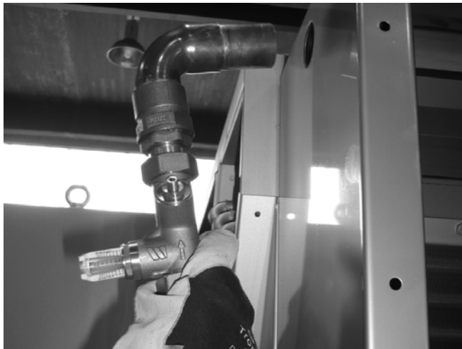
Рисунок 14: Узел подачи воды
