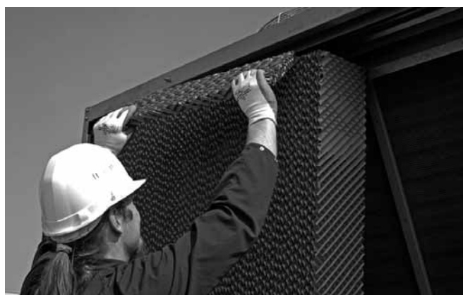
Рисунок 19: Извлечение водораспределительных панелей
