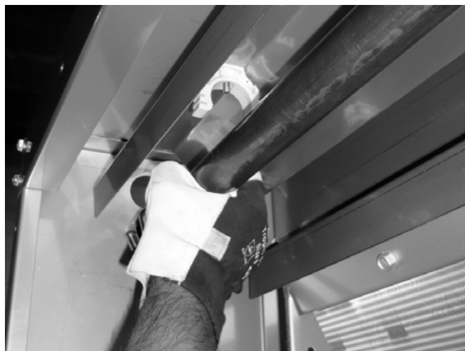
Рисунок 7: Высвободите медный коллектор из пластиковых держателей
