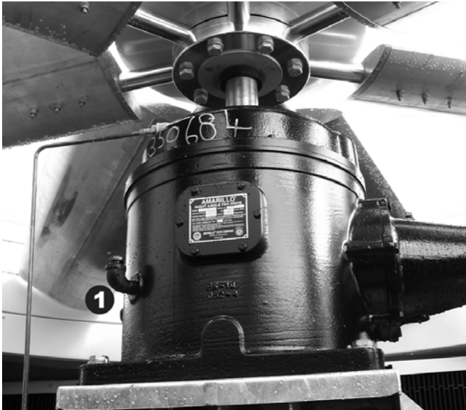
Рисунок 9: Зубчатая передача с одним редуктором
