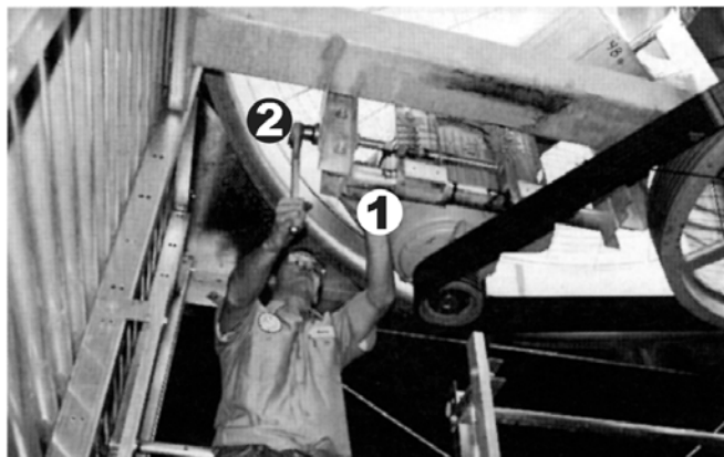
Рисунок 15: Регулируемая рама двигателя
