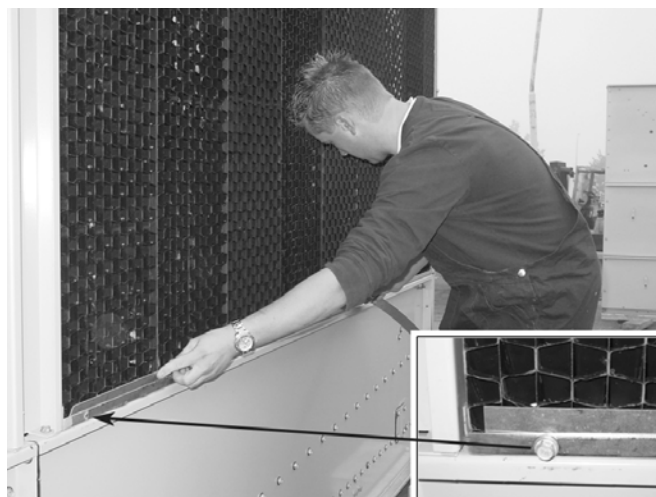
Рисунок 10: Снятие транспортных скоб
