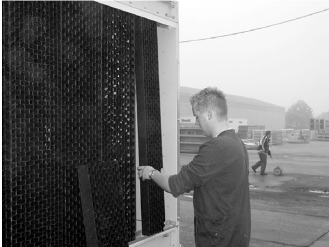
Рисунок 12: Снятие комбинированных экранов на входе
