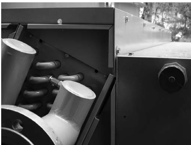
Рисунок 8: Концевой колпачок водораспределителя
