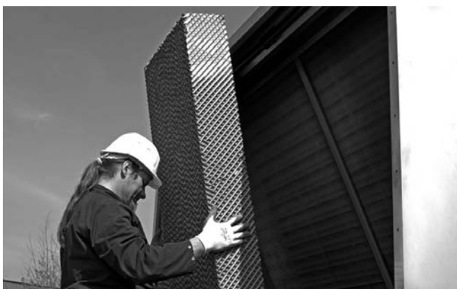
Рисунок 14: Снятие предохранительного материала
