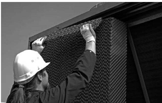
Рисунок 13: Снятие зеленых водораспределительных прокладок
