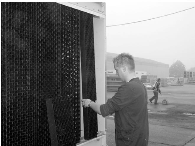
Рисунок 10: Снятие комбинированных экранов на входе
