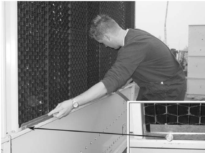
Рисунок 9: Снятие транспортных скоб
