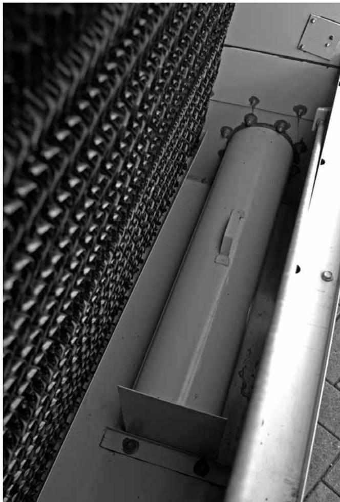
Рисунок 1: Бассейн холодной воды и сетчатый фильтр бассейна
