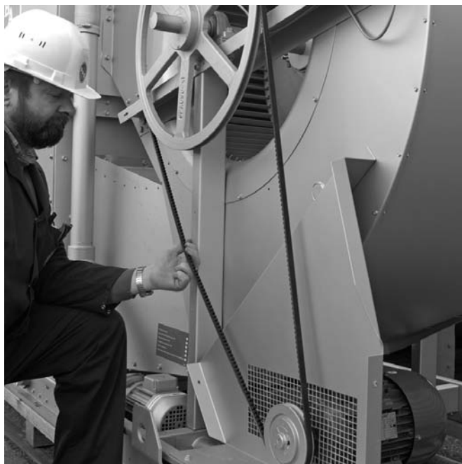
Рисунок 3: Регулировка ремня вентилятора
