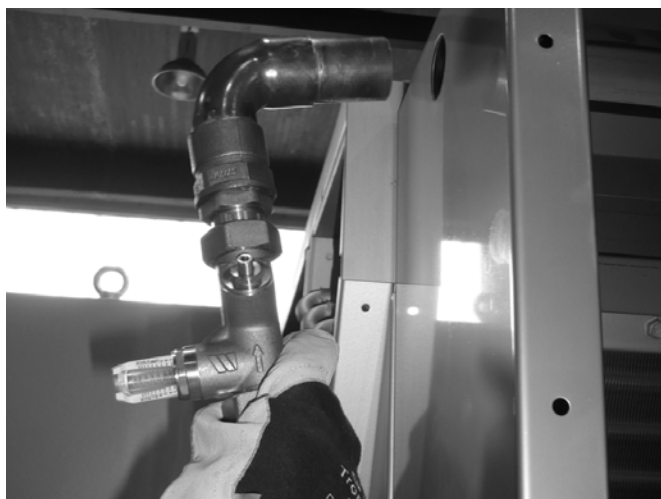
Рисунок 7: Подсоединение подачи воды
