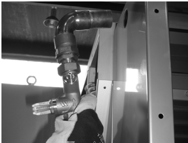
Рисунок 15: Узел подачи воды
