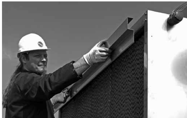
Рисунок 19: Снимите верхнюю пластину
