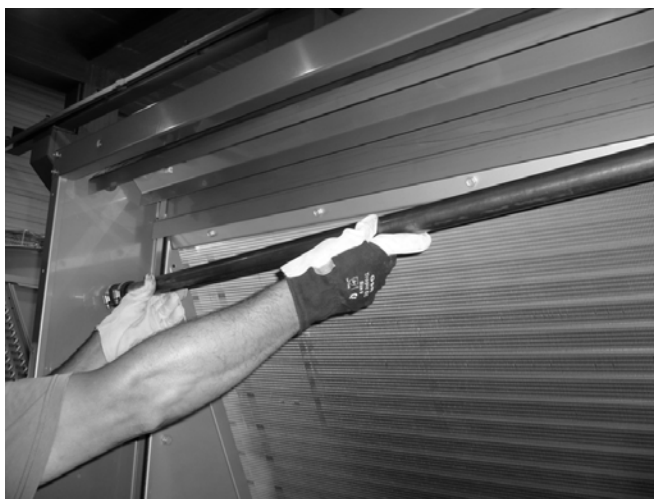
Рисунок 9: Извлеките медную трубу подачи воды
