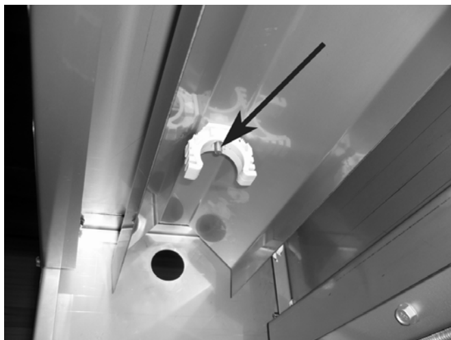
Рисунок 12: Пластиковый держатель с более длинным болтом
