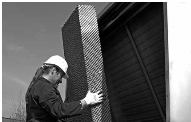
Рисунок 21: Снятие предохладительного материала
