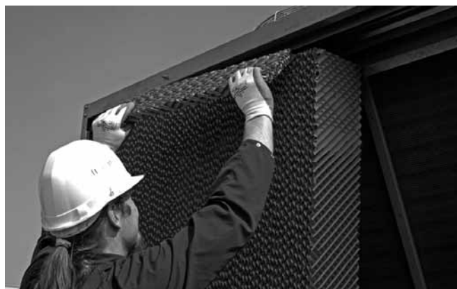
Рисунок 20: Извлечение водораспределительных панелей
