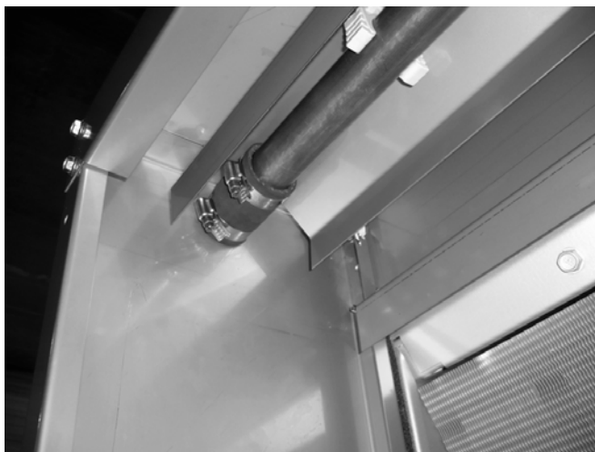
Рисунок 16: Соединение гибкого рукава с зажимами
