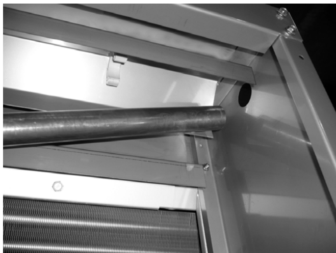
Рисунок 13: Установка медной трубы подачи воды
