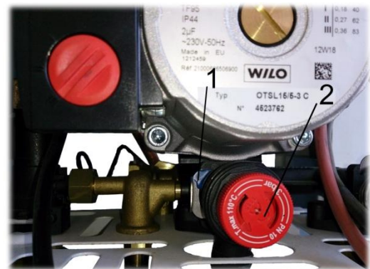
Рис. 21 Демонтаж предохранительного клапана
