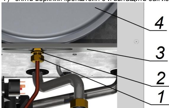
Рис. 20. Демонтаж трубы расширительного бака
