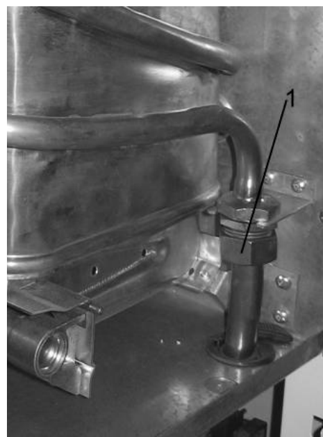
Рис. 20. Демонтаж трубы насоса
