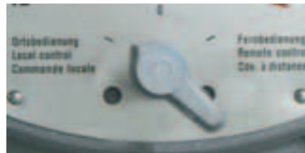
Рис. М-3: Ключ-селектор на панели местного управления
