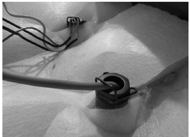
Рис. 16 – датчик температуры воды TV, установленный в отверстии котла, тип DxxP
