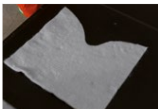
Рисунок 52. Отрежьте материал для наклонного ответвления.
