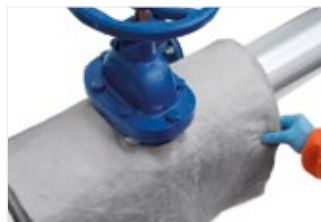
Рисунок 57. Намотка вокруг фланцев для защиты арматуры и фиксация проволокой.
