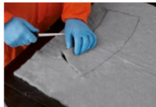
Рисунок 43. Вырежьте закругленную полосу.
