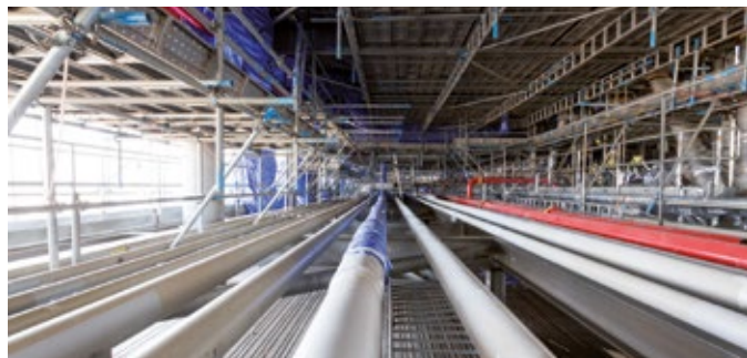
Рисунок 9. Если по прогнозу ожидаются неблагоприятные погодные условия, необходимо накрыть рабочие зоны. Не допускайте промокания изоляции.
