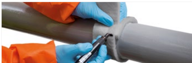
Рисунок 10. Измерение длины окружности.
