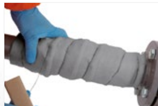
Рисунок 29. Спиральное оборачивание проволокой для фиксации ArmaGel HT на своем месте.
