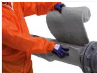
Рисунок 24. Убедитесь, что исходная точка находится на одной линии с осью трубы. Для удержания в исходном положении может понадобиться лента или клей.
