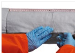
Рисунок 15. Фиксация с помощью проволоки.
