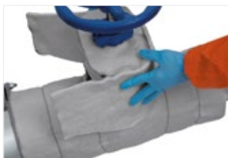
Рисунок 58. Обмотка шпинделя запорной арматуры.
