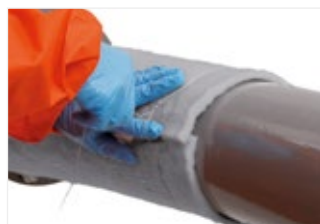
Рисунок 12. Продольный шов внахлест.
