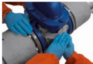
Рисунок 55. Установите ArmaGel HT вокруг корпуса запорной арматуры для предотвращения образования пустот.
