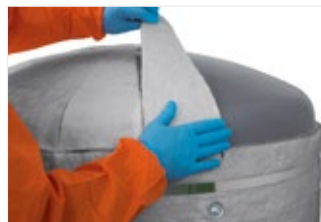
Рисунок 61. Установите плотно подогнанные сегменты и прикрепите их с помощью булавок и полосы.
