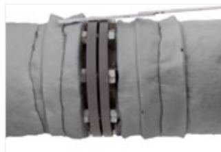
Рисунок 31. Намотайте широкие полосы ArmaGel HT шириной 50 мм (2 дюйма) для увеличения слоя изоляции, но чтобы она не заходила на фланец (или отрегулируйте ширину, чтобы она была равна общей толщине изоляции, если она > 50 мм).
