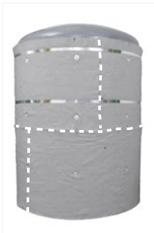
Рисунок 60. Начинайте изолировать с линии сварки дна ёмкости. Зафиксируйте лист изоляции ArmaGel HT с помощью булавок, чередуя соединения в шахматном порядке, а затем привяжите каждый слой к ёмкости полосой.
