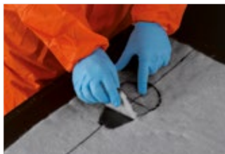
Рисунок 50. Сделайте вырез для наклонного ответвления.
