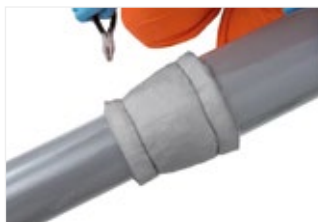
Рисунок 44. Установите ее вокруг переходника и затяните проволокой на своем месте.
