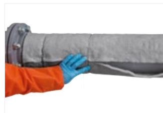
Рисунок 14. Последующее формирование шва, устранение зазоров.
