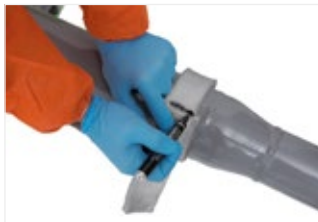
Рисунок 42. Измерьте обе длины окружности по сварному шву.
