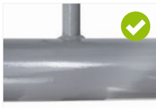
Рисунок 7. Убедитесь, что трубопровод чистый, сухой и без обледенения.
