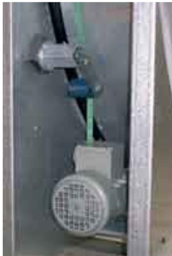
*Электродвигатель роторного рекуператора*
