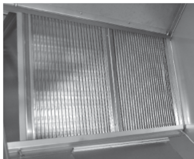
Пластинчатый рекуператор (рис. 14)
