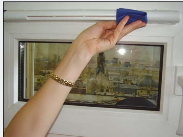
**НЕ ДОПУСКАЕТСЯ** мыть приточный клапан под струей воды и полностью замачивать.
