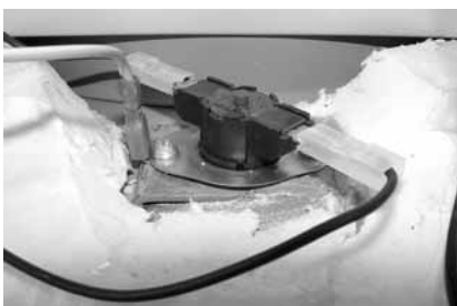
Рис. 26: Кнопка включения предохранительного термостата
