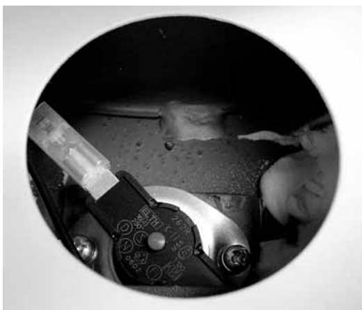
Рис. 22: Кнопка включения предохранительного термостата
