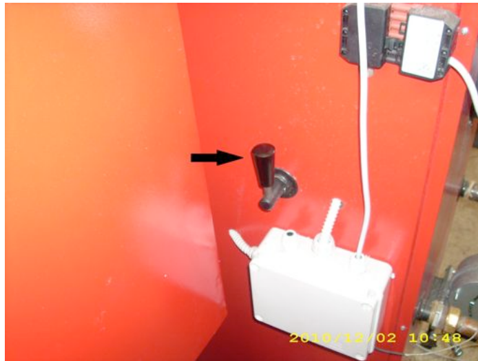
Рисунок 9. Положение ручки клапана «ПОДЖИГ»
