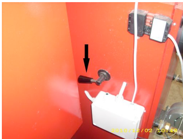
Рисунок 7. Положение ручки клапана «РАБОТА»
