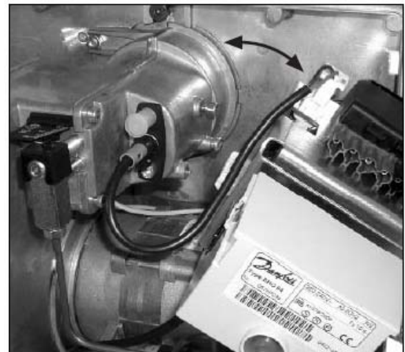
Рисунок 30 – Снятие блока управления
