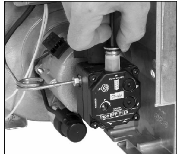
Рисунок 29 – Демонтаж топливного фильтра
