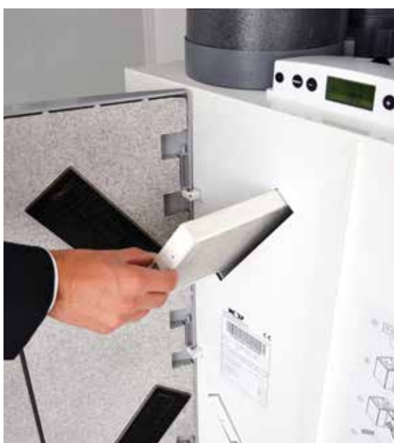
Извлекаемый фильтр, чистится обычным пылесосом
