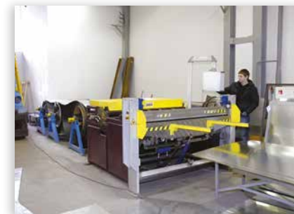
Линия раскроя рулонного проката
