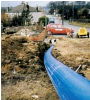
Рис. 51. Протяжка пластиковой трубы из ПЭ в Тансталле, Великобритания
