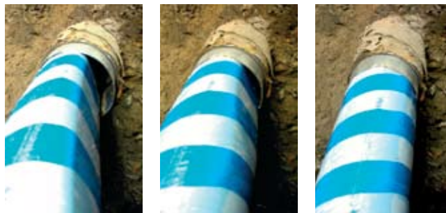
Рис. 37. Compact SlimLiner расширена с использованием «холодного» процесса
