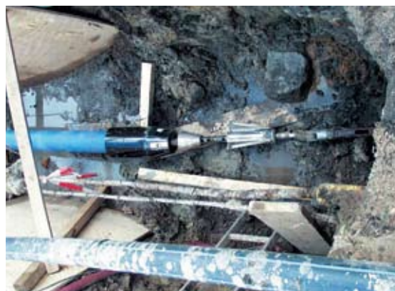
Рис. 15. Разрушение трубы
