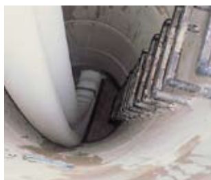
Рис. 29. Для восстановления канализации могут использоваться существующие колодцы
