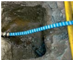
Рис. 36. Только небольшие входные и выходные котлованы нужны для установки Compact SlimLiner.
