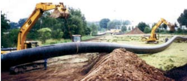
Рис. 17. Восстановление трубопровода методом протаскивания ПЭ трубы в Великобритании
