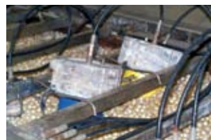
Рис. 46. Гидравлическая опрессовка (испытание на этапе «У»)
