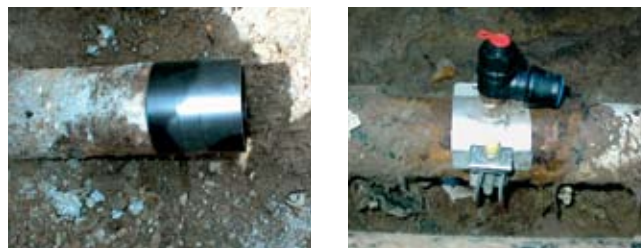
Рис. 35. Концевой фитинг и патрубок для подключения
