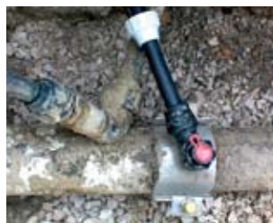
Рис. 39. Подключение отвода с использованием компактного патрубка
