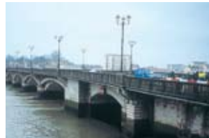
Рис. 53. Compact Pipe в Байонн, Франция
