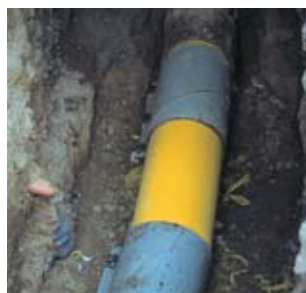
Рис. 23. Compact Pipe – из С-образной формы к плотному прилеганию
