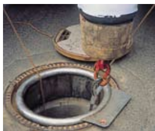
Рис. 29. Для восстановления канализации могут использоваться существующие колодцы
