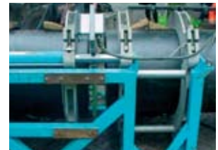
Рис. 19. Сварка встык полиэтиленовых труб
