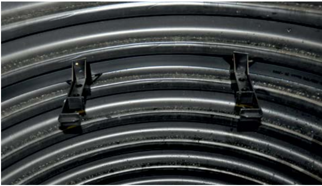
Рис. 6. Предварительный монтаж держателя лестницы в шахтной трубе.
