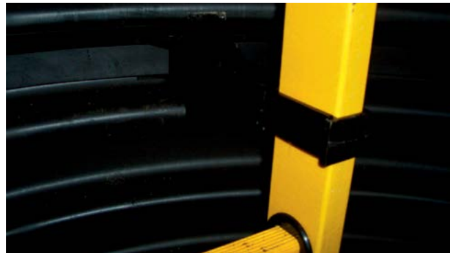
Рис. 7. Установка заглушек в кронштейны.
