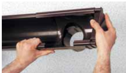
Рис. 16 Установка заглушки (внутренней)
