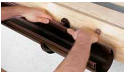
Рис. 10 Монтаж вкладки в муфту желоба
