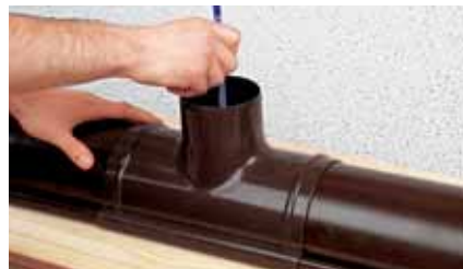
Рис. 13 Установленная водосточная воронка
