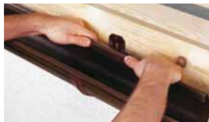
Рис. 7 Закрепление желоба в стальных кронштейнах
