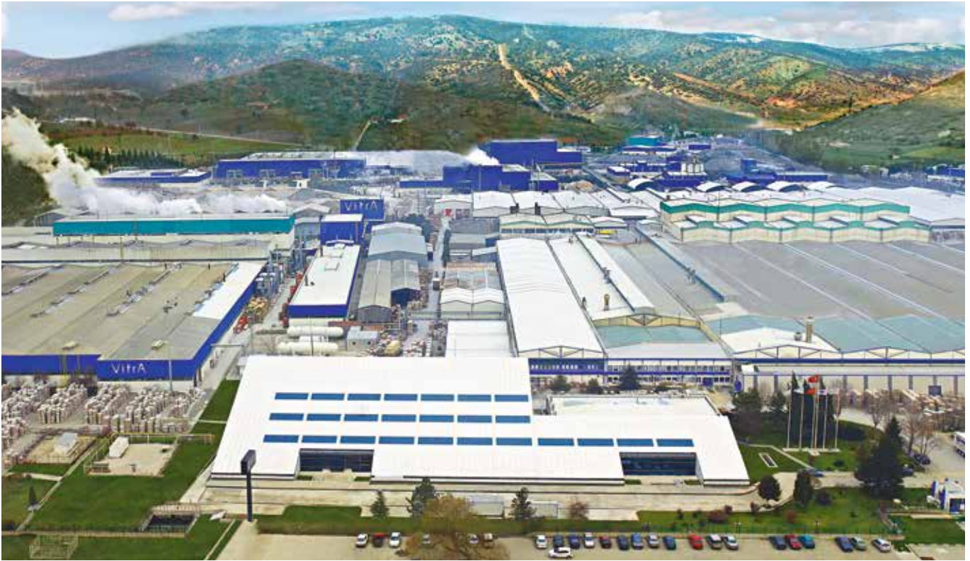
Завод Vitra по производству керамических изделий в г. Бозуюк, Турция. Общая площадь — 17 тысяч квадратных метров. Производственные мощности предприятия составляют 5 миллионов единиц в год.
