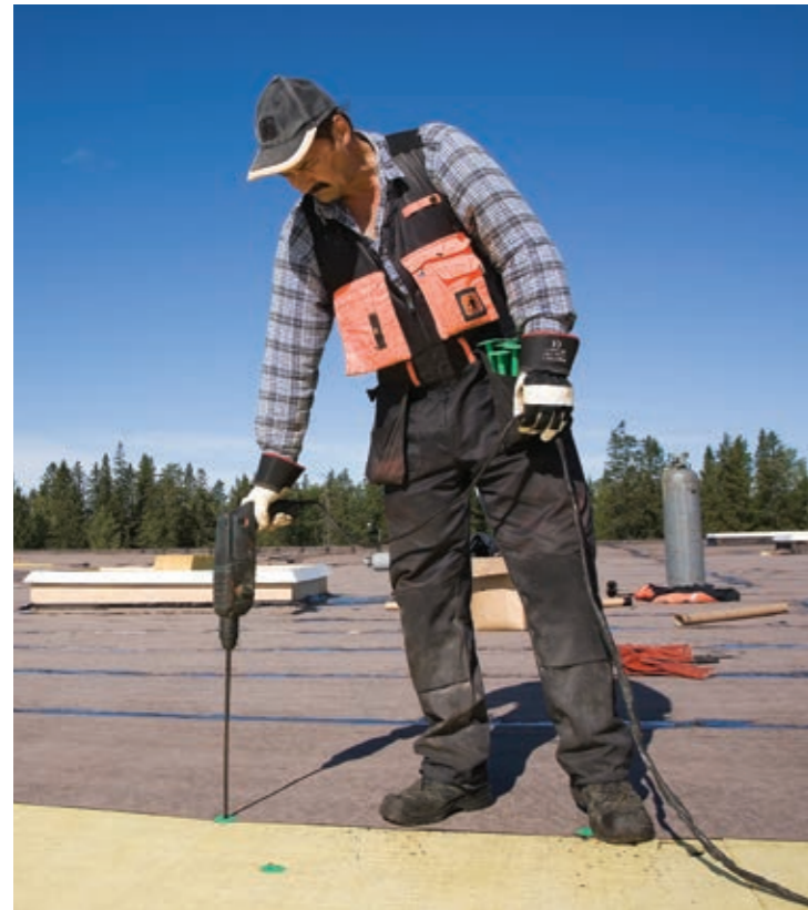
Монтаж на битумной кровле с помощью креплений CROCO с регулируемым шурупом.
