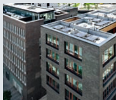
Торговый центр, Гамбург, Германия
