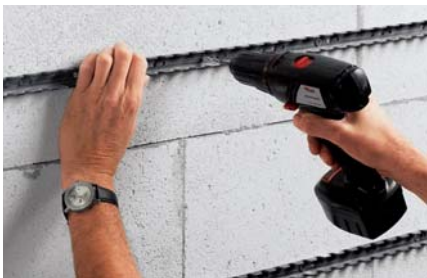
Монтаж направляющих траков. Гибкие направляющие траки Side 12 монтируются на массивной стене.
