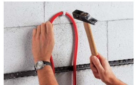
Стабилизация отводов Трубы в зоне поворотов фиксируются круглыми гвоздевыми хомутами.
