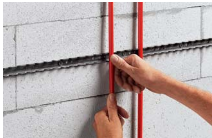
Крепление PEX-трубы Полибутиленовая труба Fonterra крепится просто и надежно в зажимные пазы.
