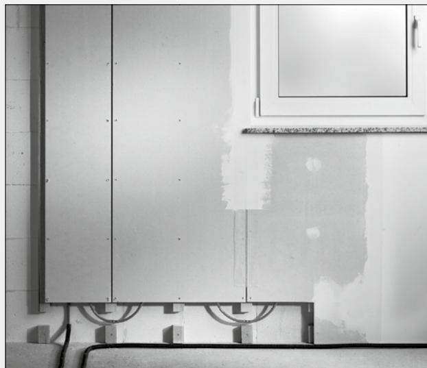
Система панельного отопления стен для сухого монтажа при ремонте и строительстве. Трубы РВ 12 x 1,3 мм уже интегрированы в стеновую панель, что исключает дополнительные шпательные работы. Монтаж происходит на стене или непосредственно на металлическом каркасе.
