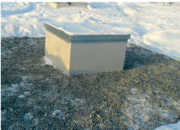
Пример правильной установки кровельного люка дымоудаления
