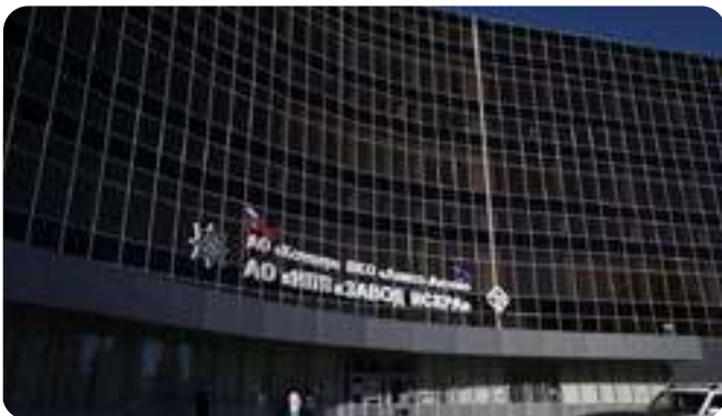
АО «НПП «Завод ИСКРА» Главный корпус блок1 г. Ульяновск.
