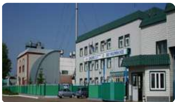
ОАО «Чишминское» Техническое перевооружение масло-прессового отделения МПЦ. Республика Башкортостан, р. п. Чишмы.
