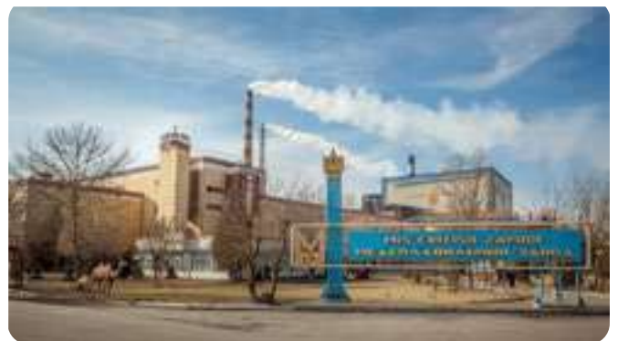
Реконструкция систем вентиляции и аспирации вельцеца цинкового завода АО «Алмалыкского ГМК». Узбекистан.
