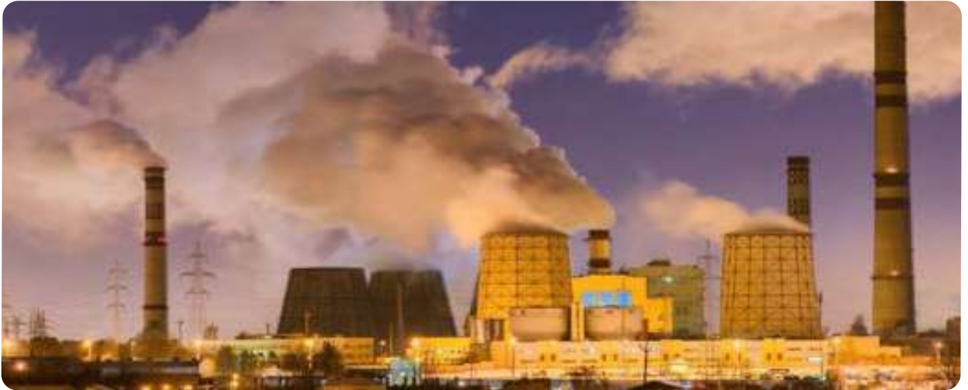
Реконструкция Минской ТЭС-3. Главный корпус. г. Минск. РБ.
