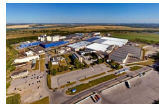
Завод «Проктер энд Гэмбл», г. Новомосковск
