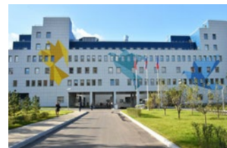
Перинатальный центр, г. Щелково
