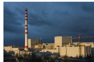
Ленинградская АЭС, г. Сосновый Бор
