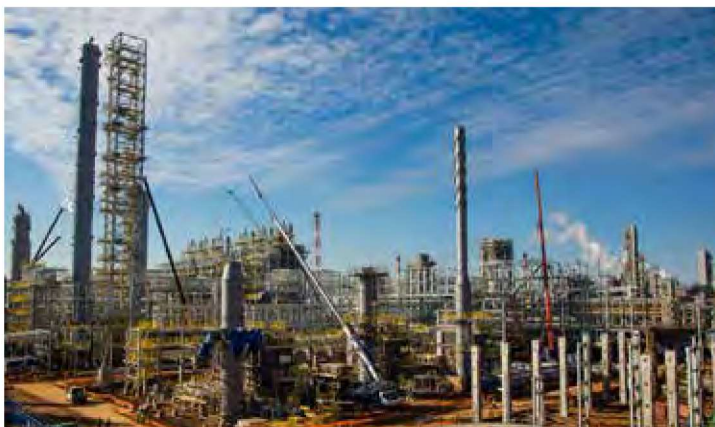
Этиленовый комплекс ПАО «Нижнекамскнефтехим».
