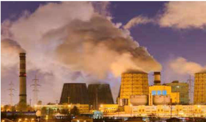
Реконструкция Минской ТЭС-3. Главный корпус. г. Минск. РБ.
