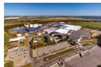
Завод «Проктер энд Гэмбл», г. Новомосковск
