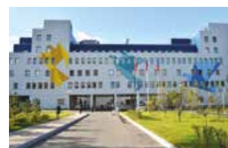
Перинатальный центр, г. Щелково
