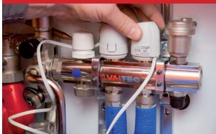
9. Подключение автоматики
