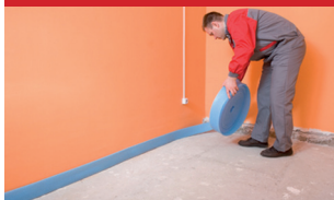
6. Укладка утеплителя (пенополистирол с покрытием).
