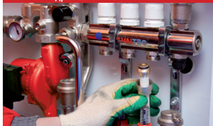
8. Подсоединение петель теплого пола к коллекторному блоку. Гидравлические испытания
