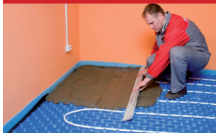
10. Заливка бетонной стяжки с пластификатором
