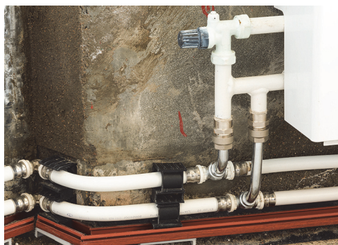
ПОДКЛЮЧЕНИЕ КОНВЕКТОРА (стадия строительства)
