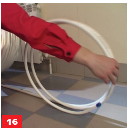
16 Вручную распрямляется отмотанный участок трубы
