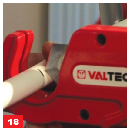
18 Отрезается требуемый кусок трубы. Это можно делать с помощью гильотинного трубореза VTm.397 в следующем порядке: - труба помещается в опорную скобу трубореза;
