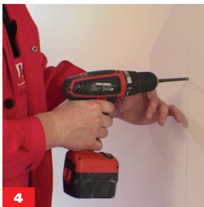
4 Высверливаются гнезда для крепления опор и водорозеток
