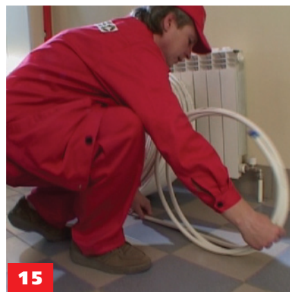
15 Отматывается необходимое количество трубы
