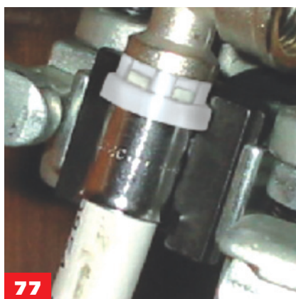
77 Инструмент заводится на фитинг таким образом, чтобы буртик гильзы вошел в соответствующее углубление пресс-насадки
