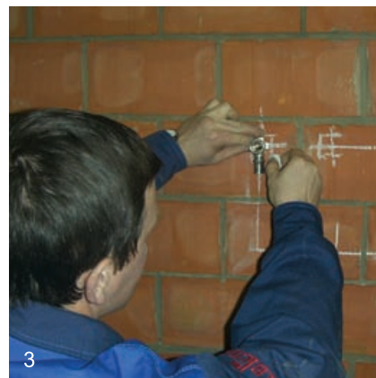
3 Намечаются места установки водорозеток
