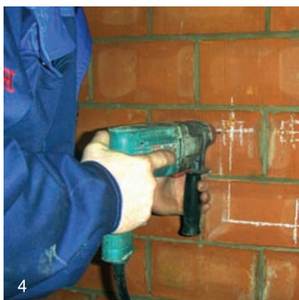
4 Высверливаются гнезда для крепления опор и водорозеток
