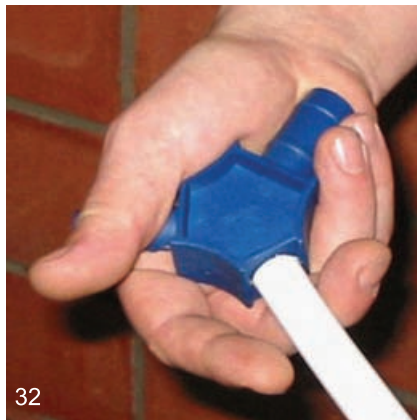
– калибровочный штырь соответствующего диаметра пластикового калибратора до упора вводится в трубу и производится 1-2 оборота относительно оси трубы
