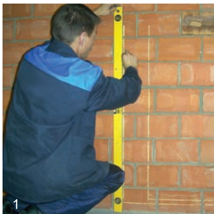
1 Разметка трассы трубопровода
