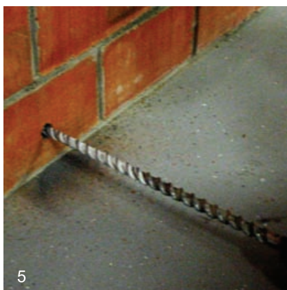
5 Пробиваются или высверливаются отверстия для прохождения трубы через стены и перегородки
