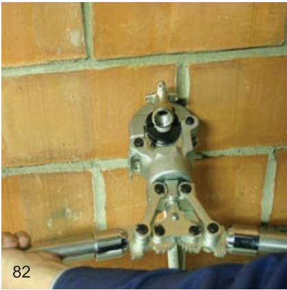
82 Для снятия инструмента с фитинга, ручки разводятся на 180°
