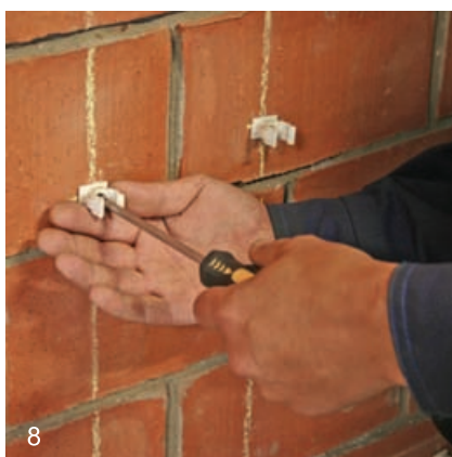
8 Устанавливаются подвижные опоры
