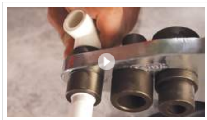
Монтаж полипропиленовых труб.
