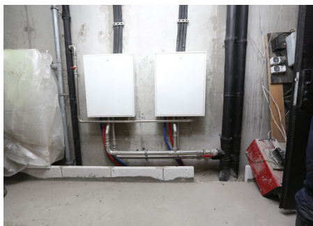
Квартирные станции VT.CSATR с теплообменником и рециркуляцией ГВС
