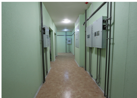
Квартирные станции VT.IVCM вертикального шкафного исполнения
