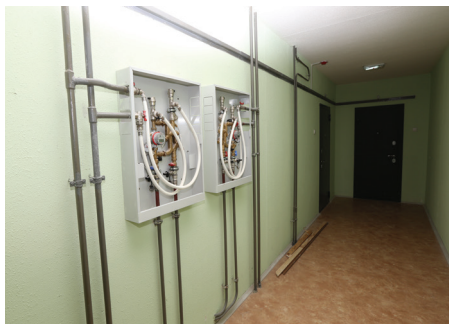
Квартирные станции VT.IVCM вертикального шкафного исполнения
