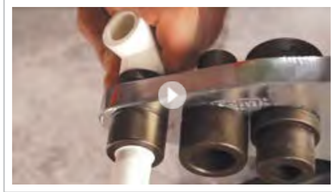
Монтаж полипропиленовых труб.
