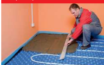
10. Заливка бетонной стяжки с пластификатором
