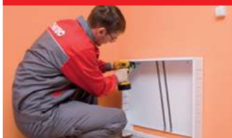
1. Монтаж коллекторного шкафа
