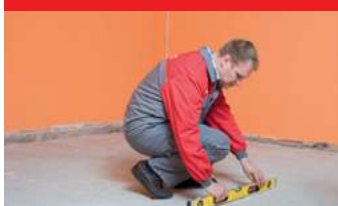
3. Подготовка поверхности пола
