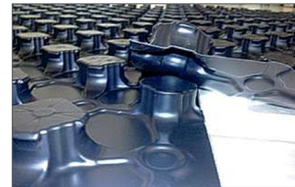
Рис. 33. Укладка плит внахлест с фиксацией края плит
