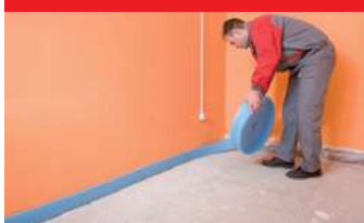
6. Укладка утеплителя (пенополистирол с покрытием)
