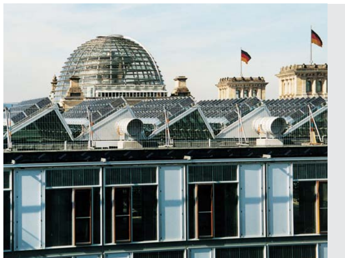
Осевые вентиляторы на крыше здания правительства, Берлин (Германия)
