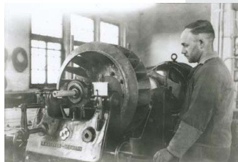
Изготовление рабочих колец центробежных вентиляторов в г. Бад-Херсфельд на пороге двадцатого века.
