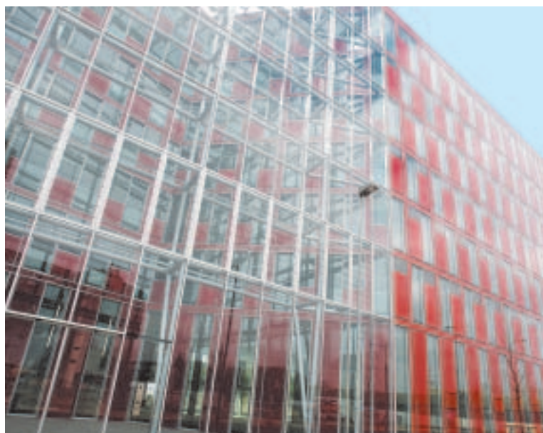
Офисное здание Carpiot, Дюссельдорф, Германия
