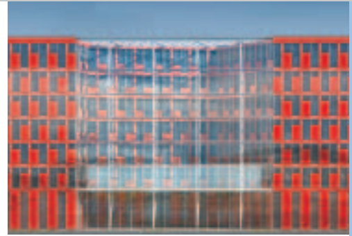
Caricom House, Дюссельдорф, Германия
